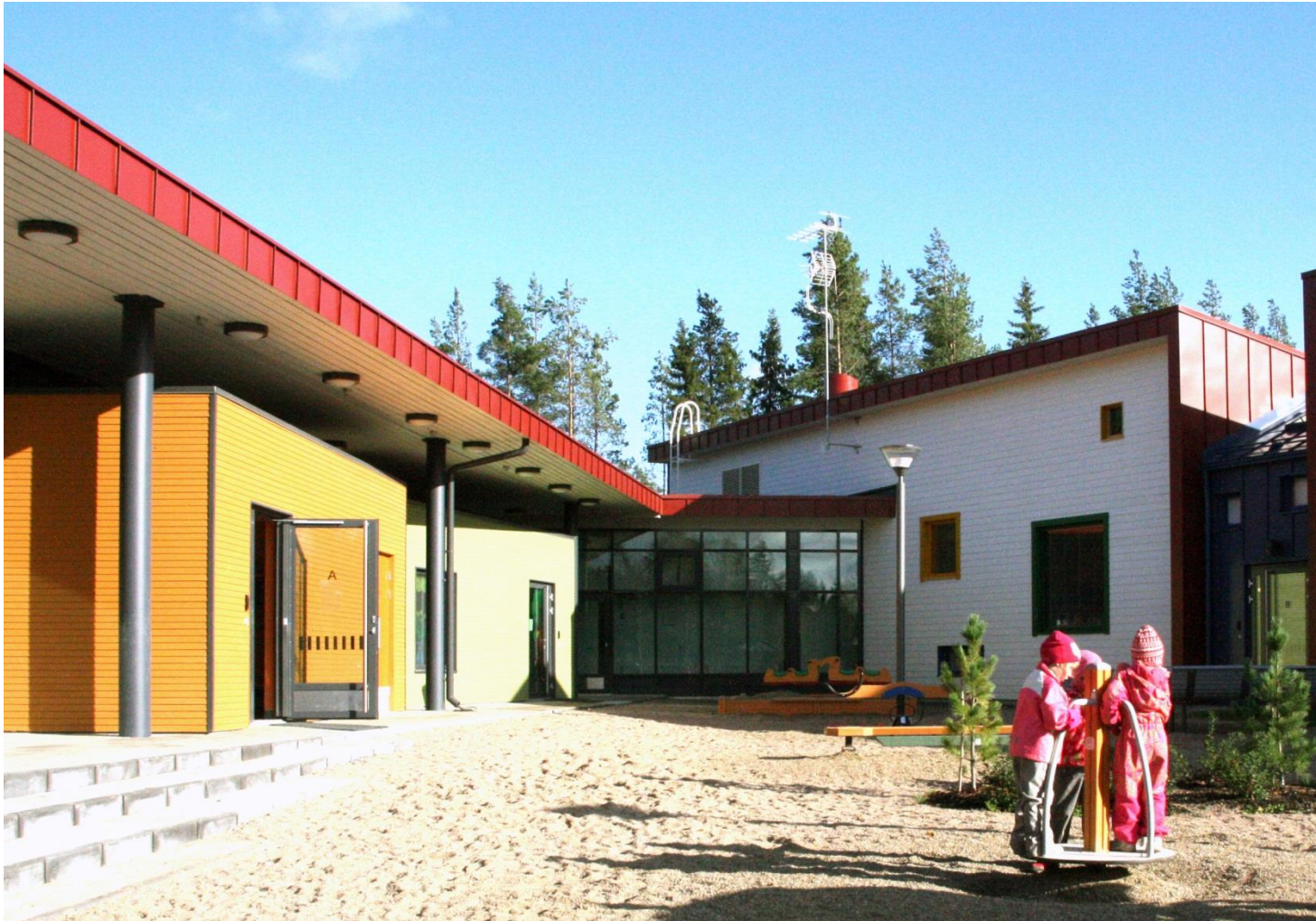
Käpälämäen päiväkoti Ilmajoen Aholankylällä. Arkkitehtitoimisto Pekka Lassila 2010. Kuva: Helena Teräväinen.
